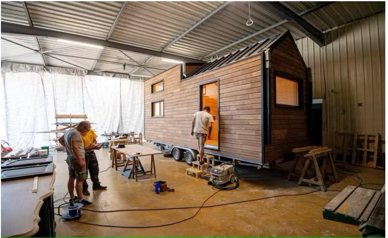
Tiny house en cours de construction : Entreprise Deux Arches à Wavrin (Nord)
