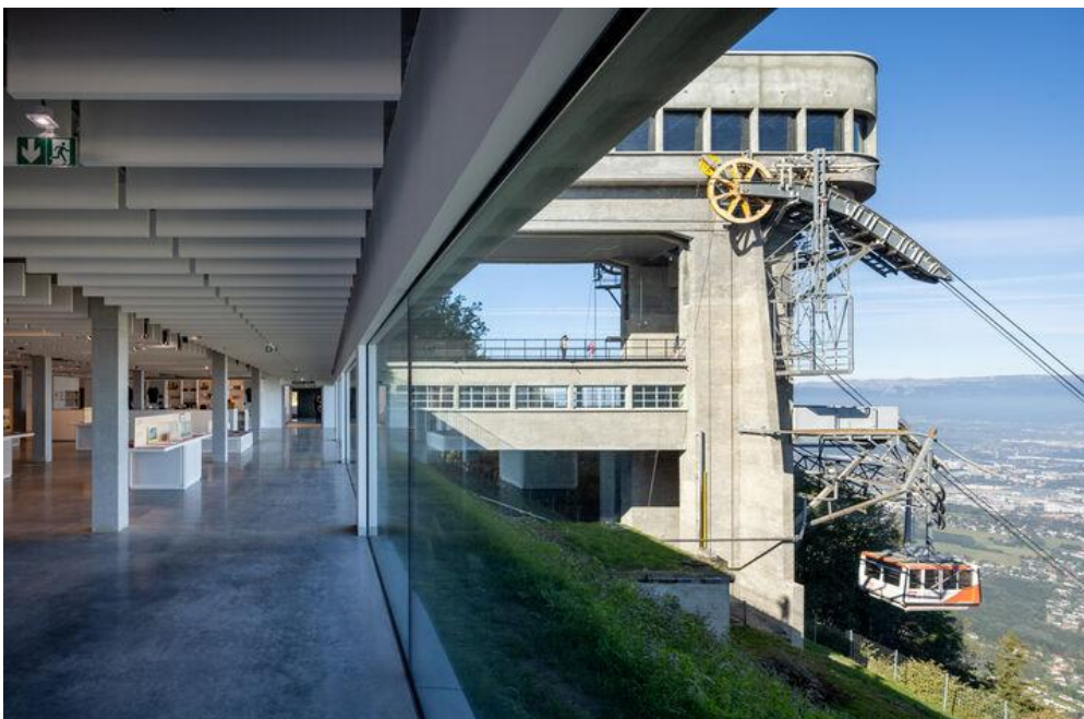
Réhabilitation de la gare haute du téléphérique du Salève à Monnetier-Mornex (Haute-Savoie)
